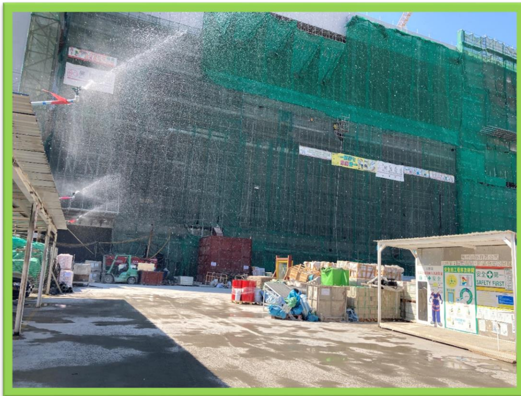
行車通道加設自動灑水系統及水喉灑水以減低塵埃飛揚
