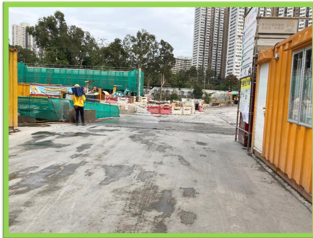
行車通道加設自動灑水系統及水喉灑水以減低塵埃飛揚
